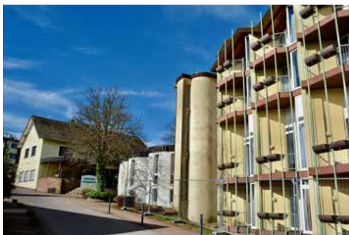
Bald schon soll hier Altes Neuem weichen © se
