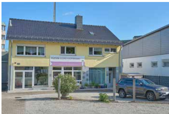
Aussenansicht der Firma Fliesen Georg und Hoffmann GmbH in der Saarbrücker Straße 74
