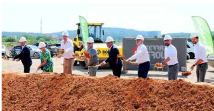
Der 1.Spatenstich zu dem Wasgau-Supermarkt war gleichzeitig auch der offizielle Baubeginn am künftigen Stadtviertel Coeur © Heinz Hollinger
